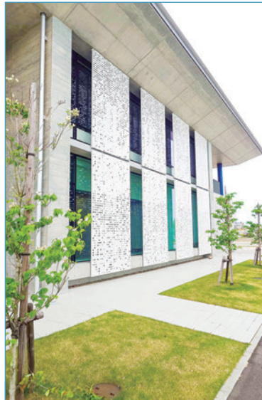
入善庁舎 / 日射抑制パネル
