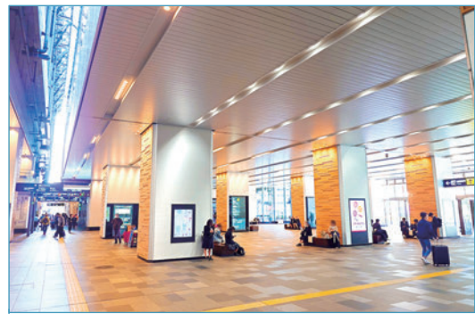
富山駅南北自由通路 / 天井_天井有孔アルミスバンドレル 柱_内壁スバンドレル
