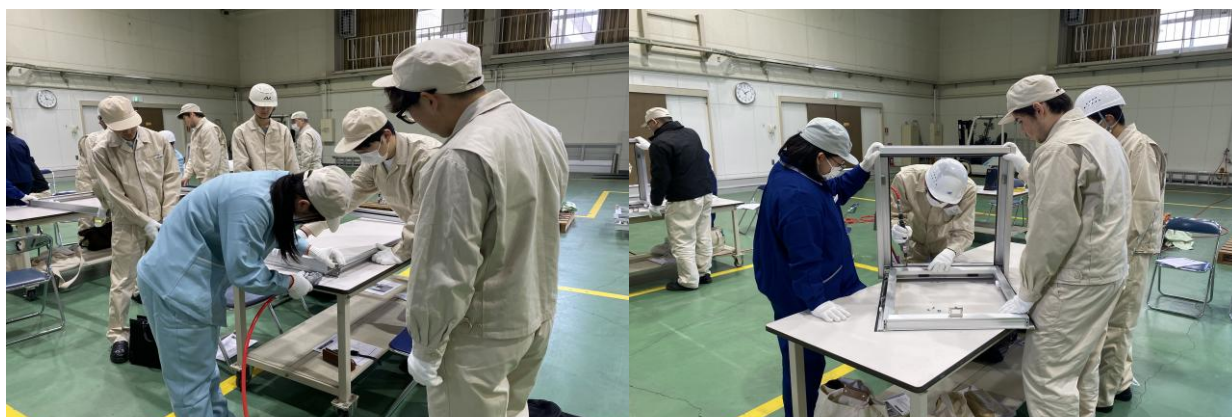
建具の構造と各部品の機能を確認、慣れないエアードライバーで組立する受講生
