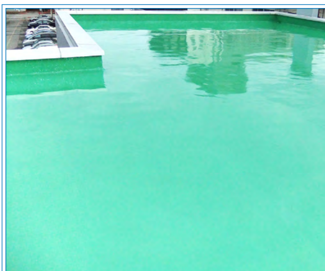
■ 屋上防水塗装を綺麗に仕上げます
