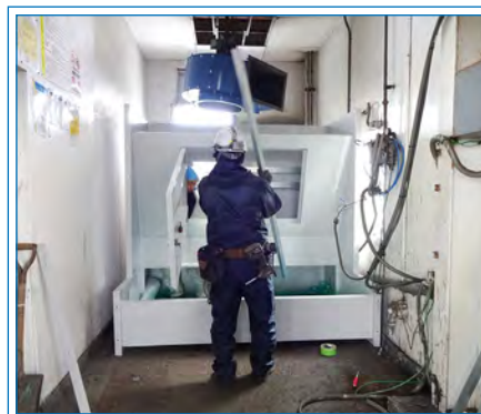
■ 塗装ブース設置工事を承ります
