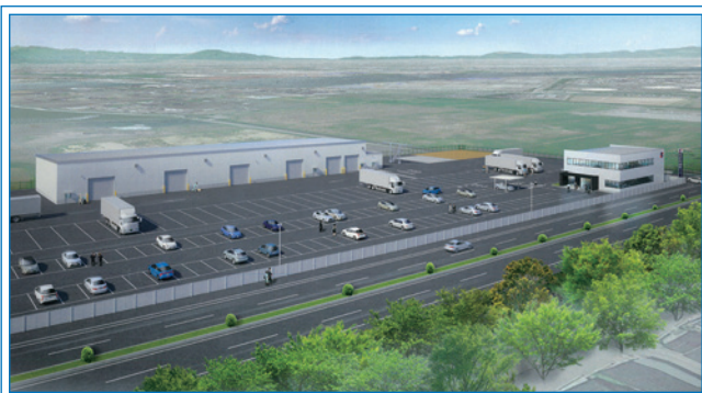
射水市有磯地区に建設中、来春竣工
