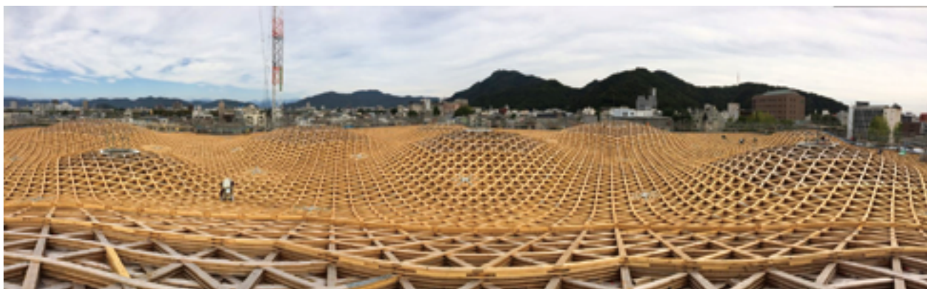
「ぎふメディアコスモス」の木材架構屋根
