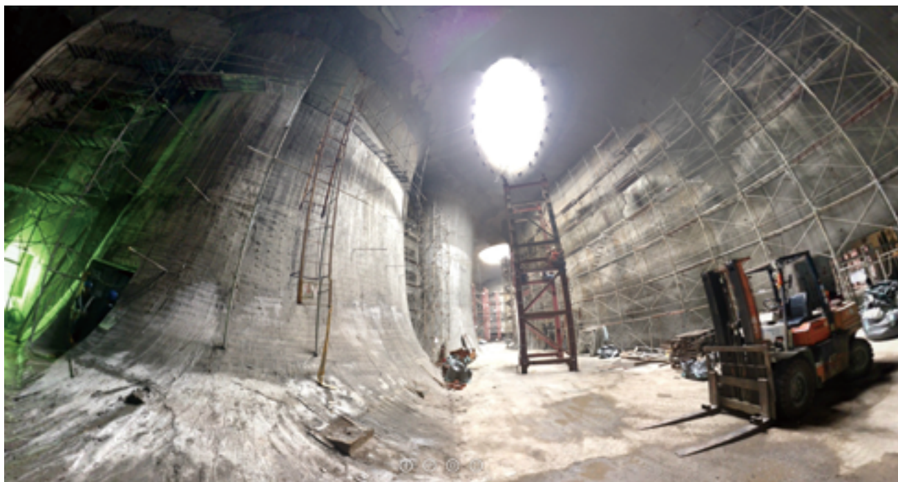
「台中国家歌劇院」カテナイド状コンクリート躯体建設現場 建築家／伊東豊雄
