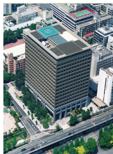
都道府県会館 (外装カーテンウォール)
