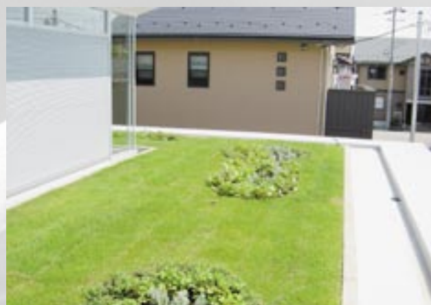
屋上緑化・屋上菜園
