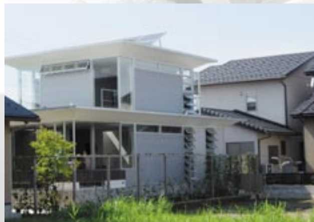
太陽光パネル(2F屋根)
