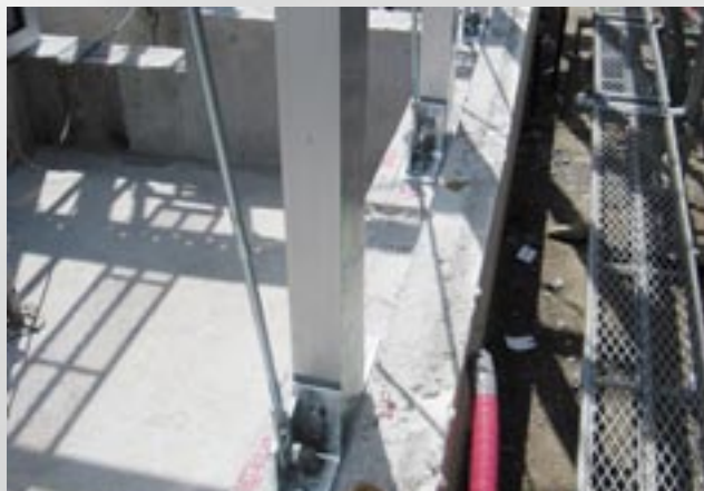
今回開発されたアルミリングを用いた構法システム
