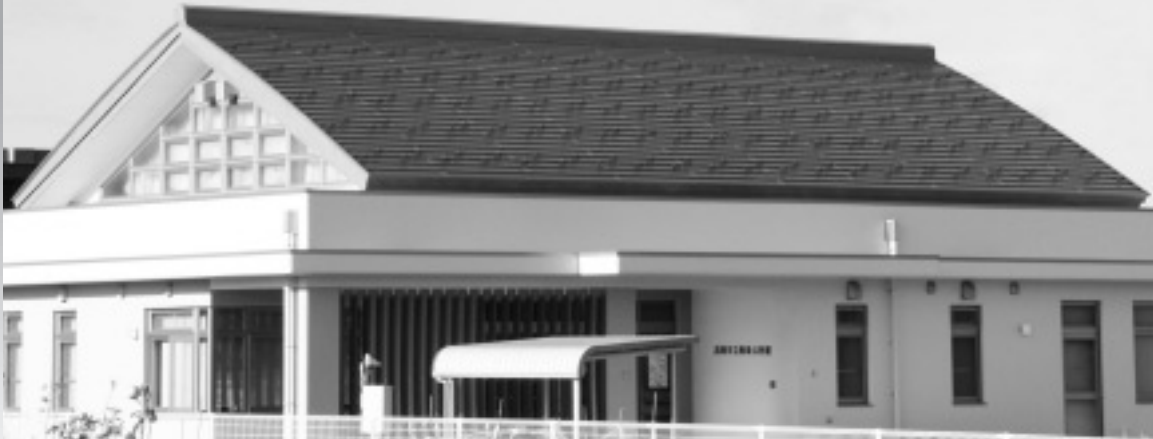
高岡市立西条公民館 屋根:アルアピアを使用 (設計)株式会社GA開発研究所 (アルミ型材供給元)三協立山アルミ株式会社
