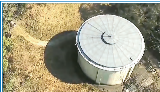
アルミニウム合金製覆蓋事業 施工実績／奈良県斑鳩町配水池
