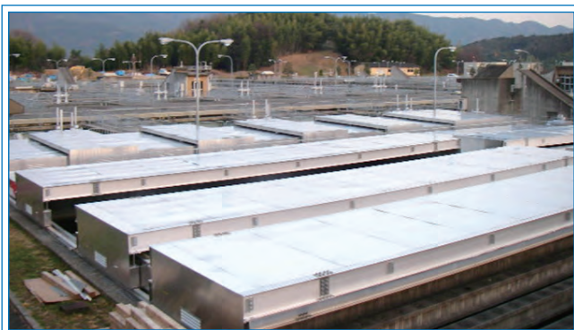
アルミニウム合金製覆蓋事業 施工実績／京都府新山科浄水場
