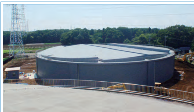
アルミニウム合金製覆蓋事業 施工実績／埼玉県上赤坂ポンプ場
