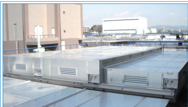
アルミニウム合金製覆蓋事業 施工実績／兵庫県千僧浄水場
