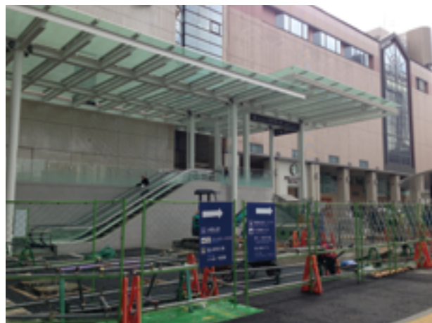
富山駅エスタ前●ガラスシェルター
