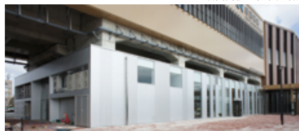
新高岡駅●中廊下外観
